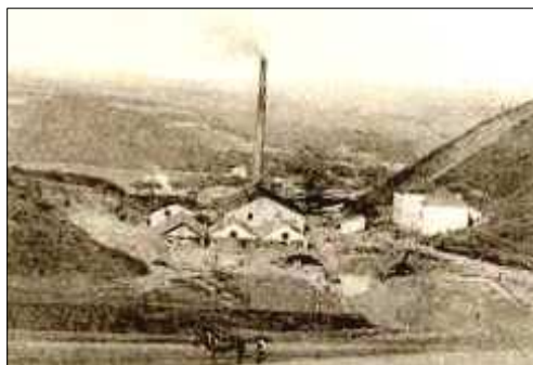
Cihelna pod Červeným vrchem
